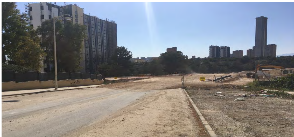
Topografía y morfología actual: zona estado de obras por la reforma y ampliación de las instalaciones del Hotel Poseidón Playa.
